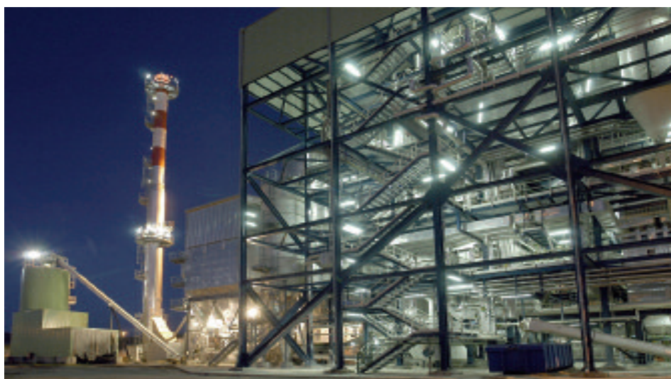
Centrale elettrica di Cutro (Crotone)
