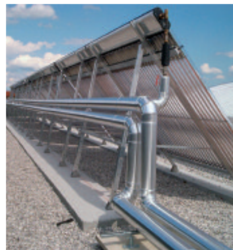
Un collettore raccoglie i tubi solari sottovuoto
