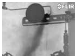
Perdita di gas metano
