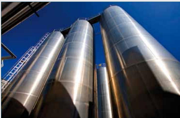
Fig. 3 - I silos dei polimeri in uno stabilimento per la fabbricazione delle membrane
