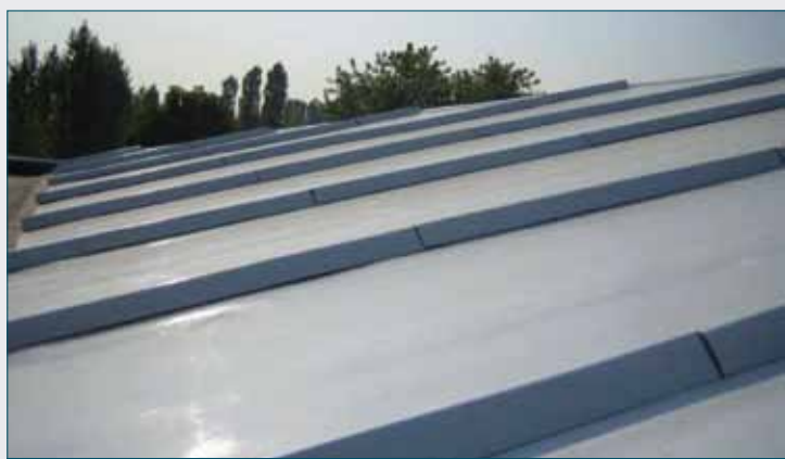
Fig. 7 - Tetto bianco riflettente realizzato con membrana bitume-polimero
