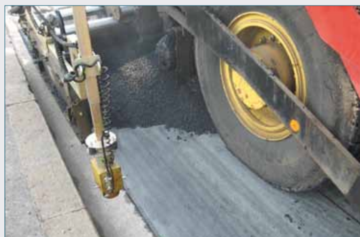
Fig. 6 - Asfaltatura dopo la posa della membrana come diaframma
