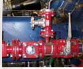
Valvole rivestite PTFE/PFA per prelievo campioni vuoto - azoto a magazzino
