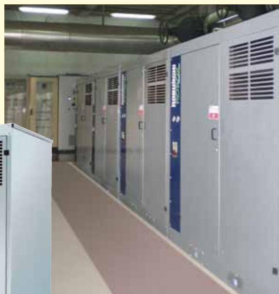
Sala compressori con Robuschi ROBOX evolution
