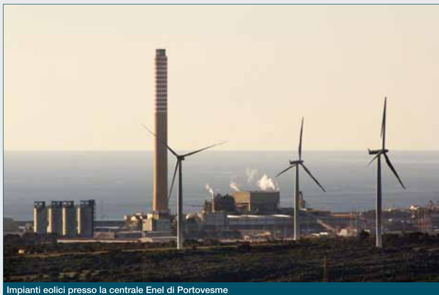
Impianti eolici presso la centrale Enel di Portovesme
