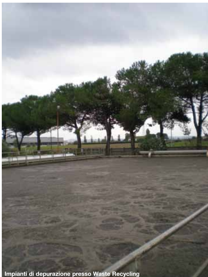
Impianti di depurazione presso Waste Recycling
