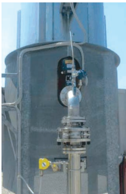
Fig. 5 Arrestatore di fiamma, valvola di regolazione e misuratore di portata
