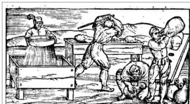
Fig. 2 - Procedure di separazione dei grezzi minerari per separare oro da argento (Biringuccio 1550 f. 70 r)
