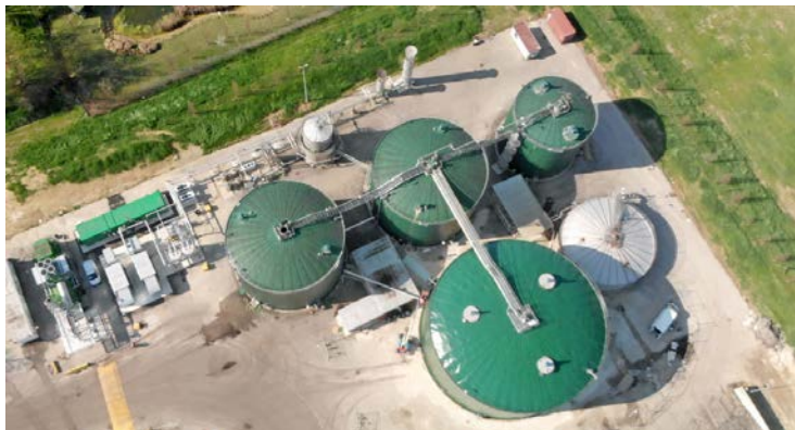
Tipico impianto di biogas
