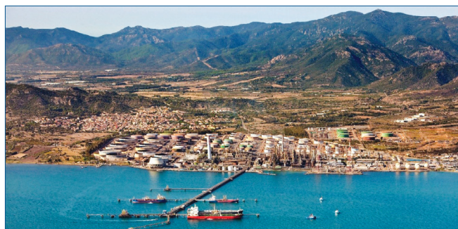
Veduta della raffineria Saras
