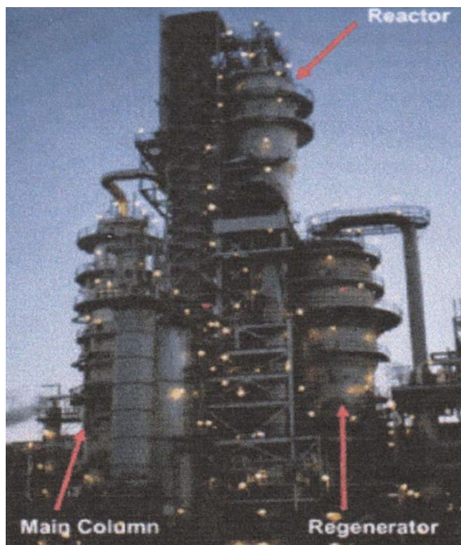
Fig. 5 Una tipica unità di cracking catalitico in una raffineria di petrolio
