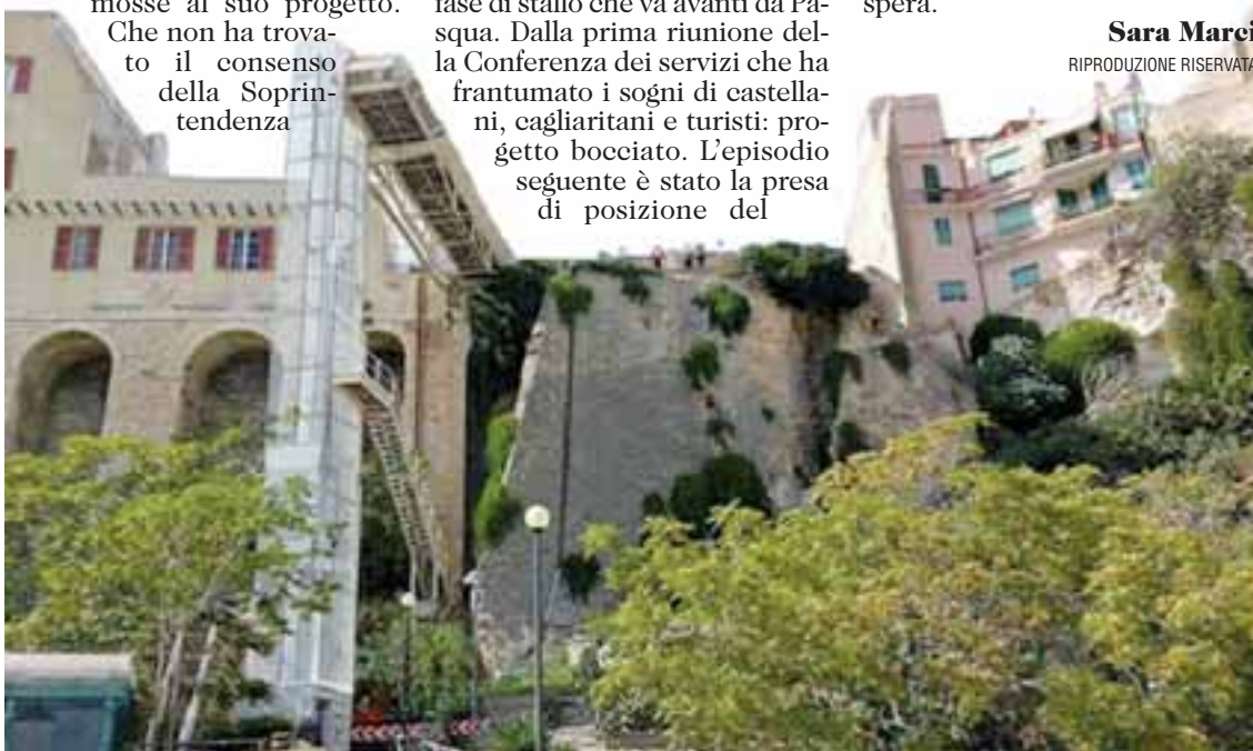
L'isolamento del quartiere di Castello è un problema da risolvere al più presto
