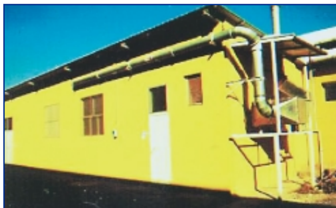
Figura 3 - Cantiere fisso utilizzato per decontaminazione da amianto su manufatti trasportabili
