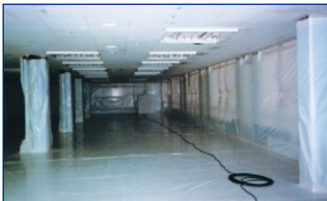
Figura 2 - Cantiere di decontaminazione allestito in un edificio adibito ad attività commerciale
