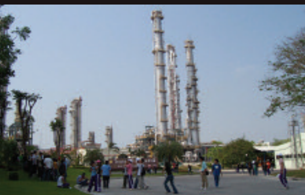
Impianto di separazione di gas naturale
