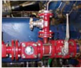
Valvole investite PTFE/PFA per prelievi campioni vuoto - azoto a magazzino
