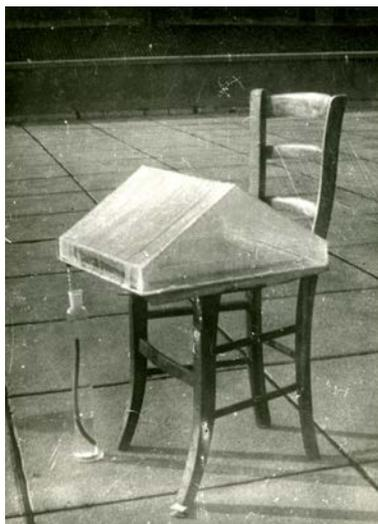
Fig. 3 - Distillatore solare di Giorgio Nebbia
