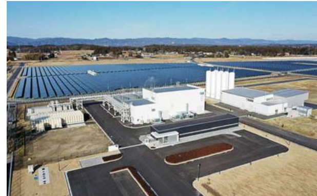
Più grande elettrolizzatore al mondo (10 MW) alimentato da un impianto fotovoltaico (20 MW, 18 ettari)
